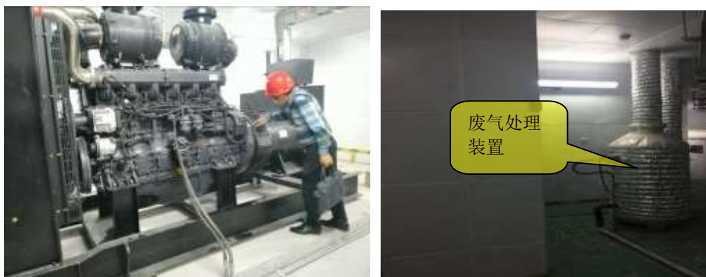
备用发电机及废气处理装置
