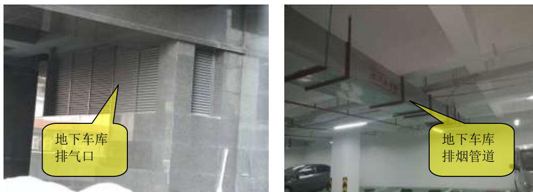
地下车库排气口及排烟管道
