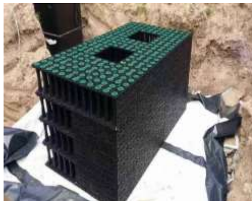
雨水过滤设施
